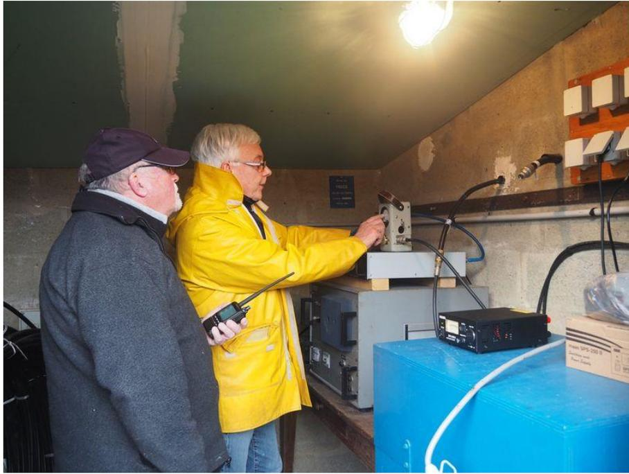
Mesure des performances au Bird 43. Sur le coffret du duplexeur (bleu) l'alimentation du nouveau relais
