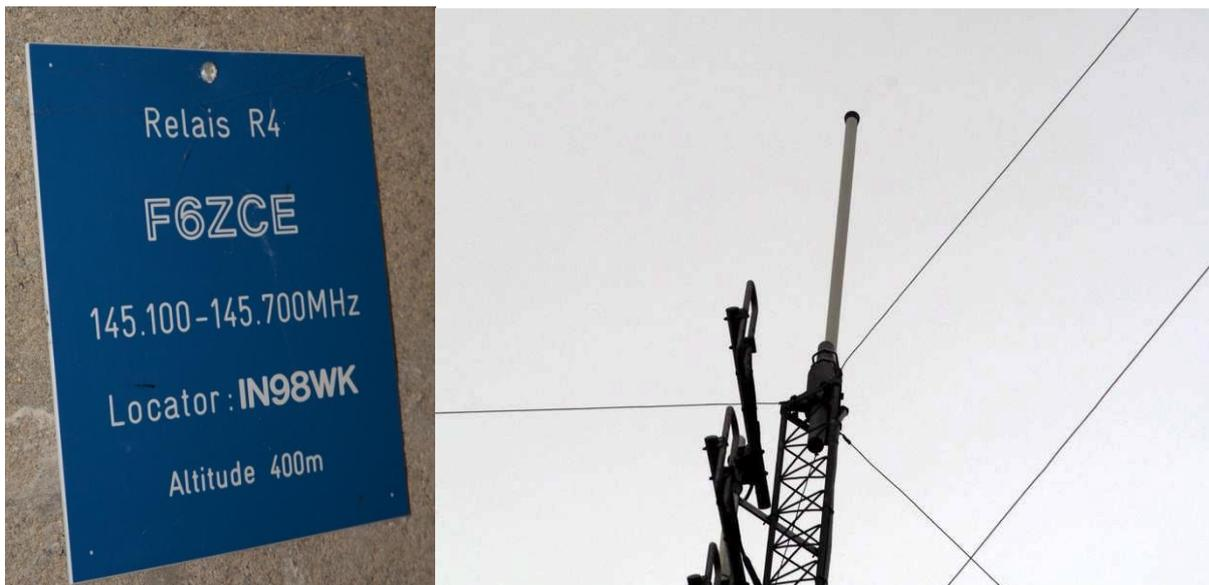
L'antenne Active est une Procom 3dB située au sommet du Pylône de 40m
